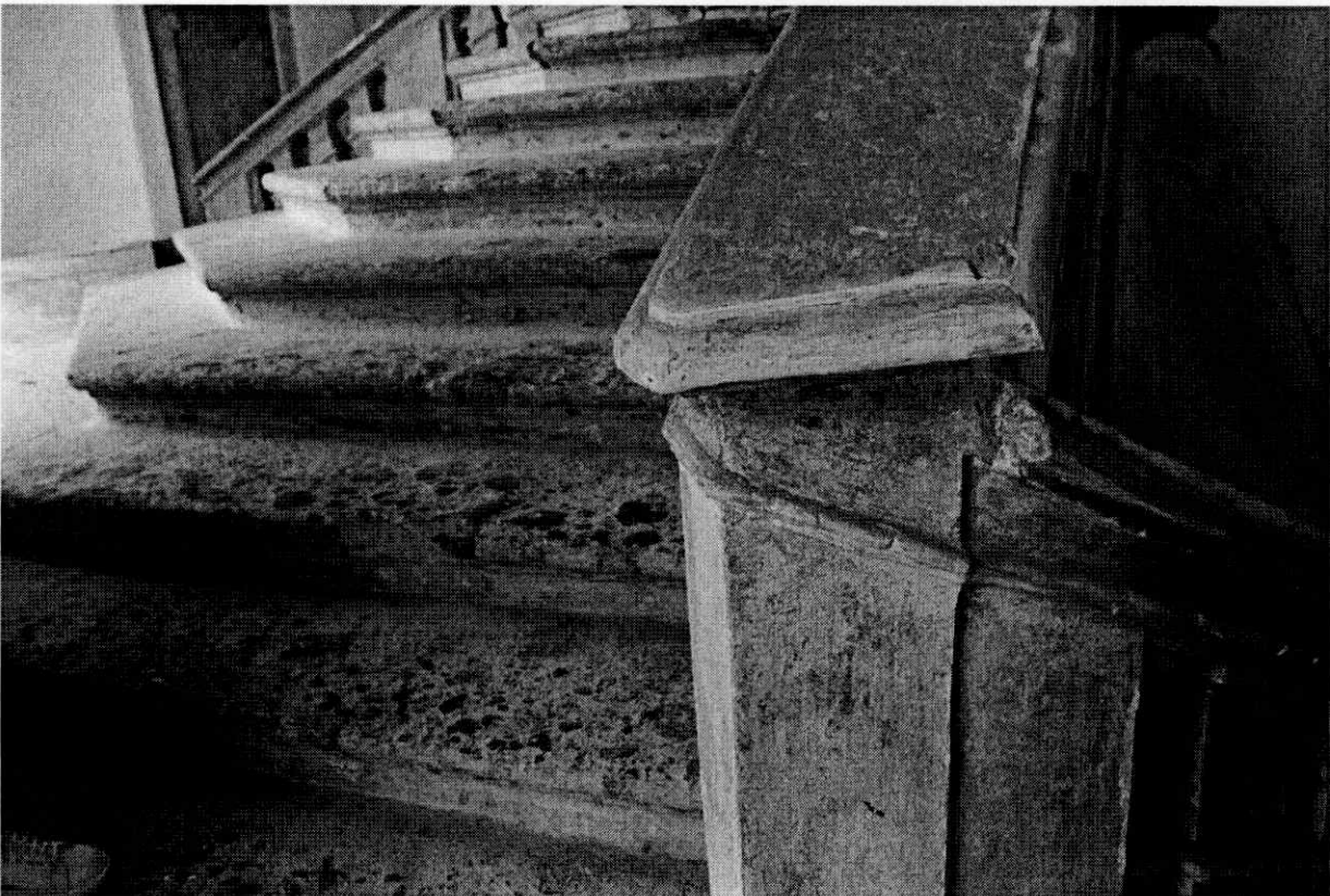
Particolare scalone monumentale, volta d'ingresso con evidenti segni di degrado.
