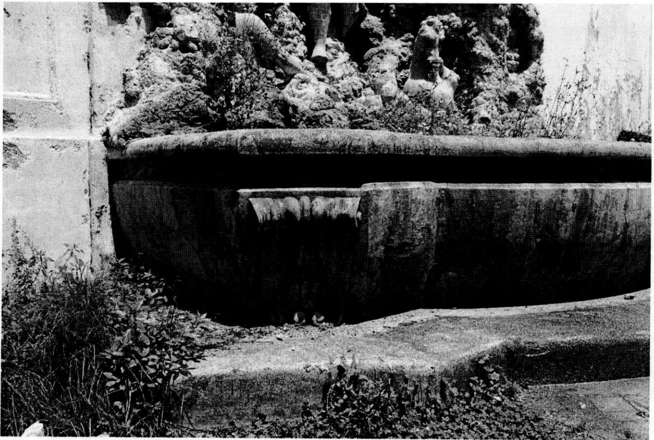
Particolare vasca della Fontana di Nettuno, Infestazione vegetale, colatura di vernice e alterazioni cromatiche.
