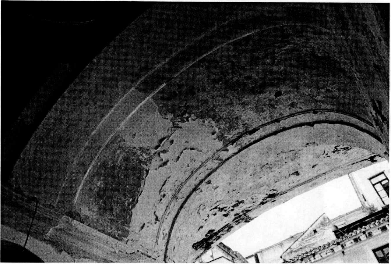
Particolare scalone monumentale, volta d'ingresso con evidenti segni di degrado.
